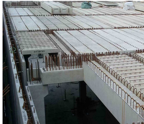
그림 A.6 — 벽체(wall)+보(girder) 접합부
