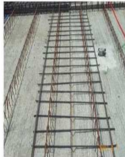
그림 A.7 — 슬레브(half slab)와 슬레브(half slab) 접합부
